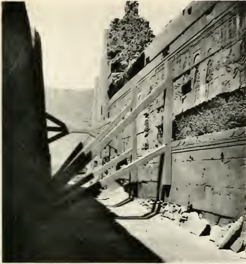
Consolidation du mur Est de l'enceinte du temple de Kom Ombos.
